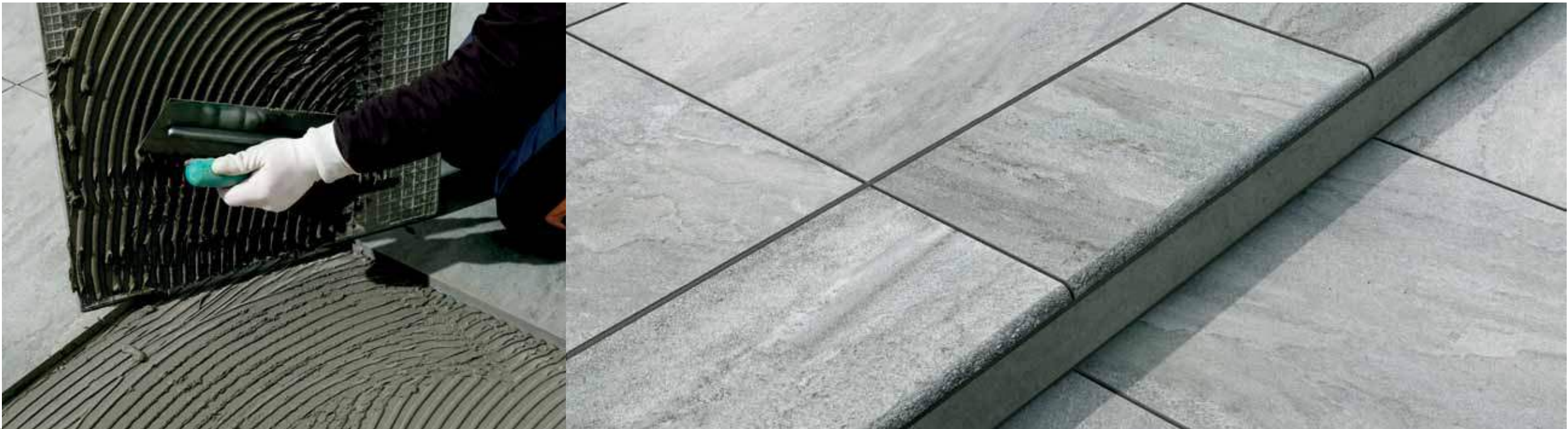
STENDERE L'ADESIVO IN MODO OMOGENEO SECONDO LA TECNICA DELLA DOPPIA SPALMATURA (SIA SUL FONDO CHE SUL RETRO DELLA PIASTRELLA)
