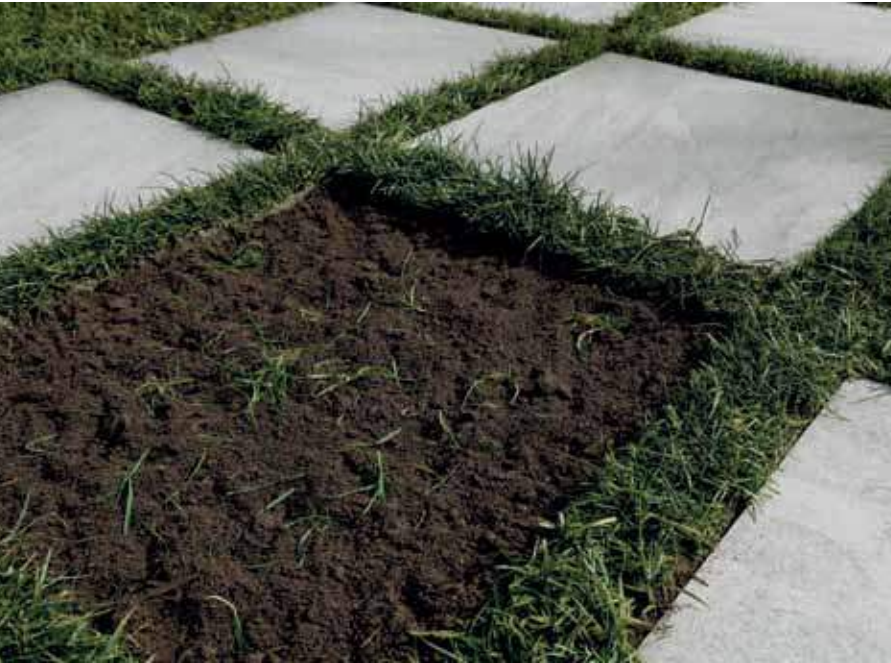
POSIZIONARE LE PIASTRELLE DISTANZIANDO LE A PIACERE A SECONDA DELL'EFFETTO ESTETICO CHE SI VUOLE OTTENERE E RIMUOVERE LA SUPERFICIE ERBOSA
