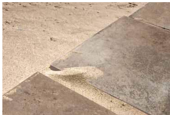
Posa su ghiaia o sabbia
